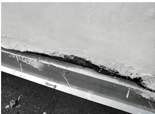
**Примыкание фартука к стене вент.канала не промазано герметиком** - затекание дождевых и талых вод.
